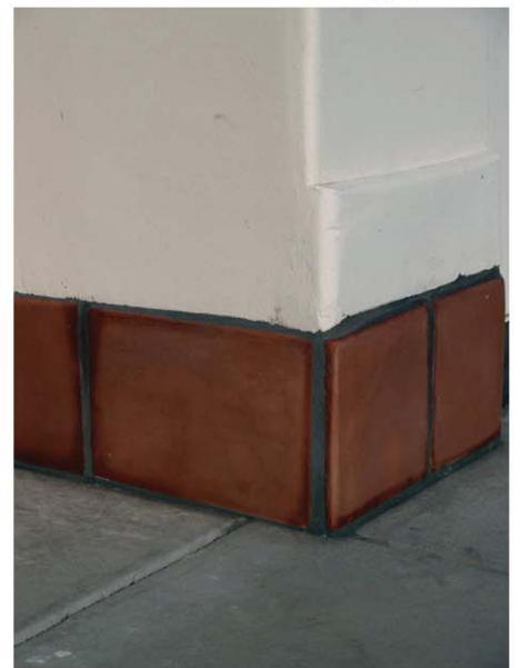
Wall Surfaces 3.jpg
