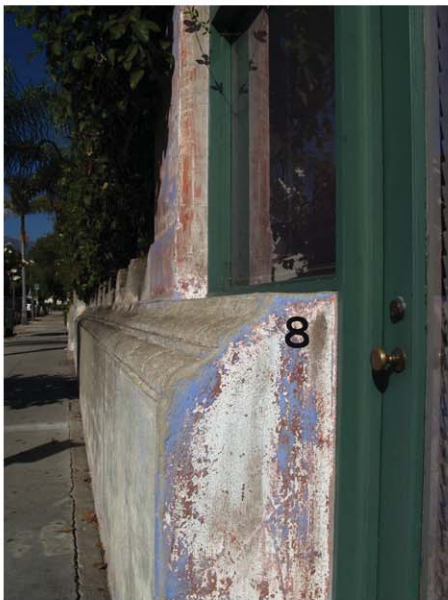
Wall Surfaces 4.jpg
