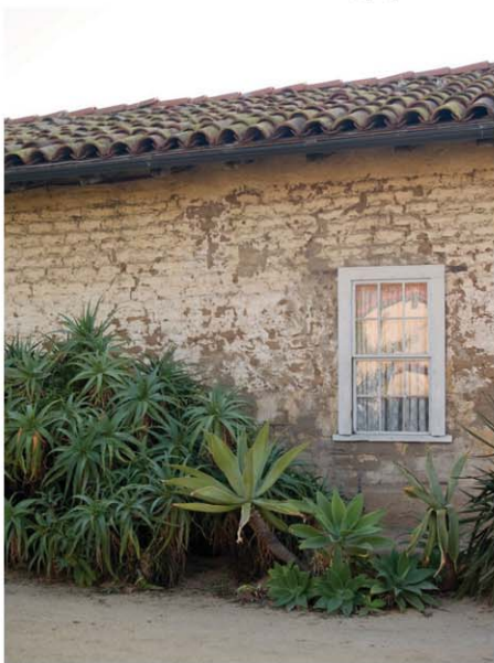
Wall Surfaces 11.jpg
