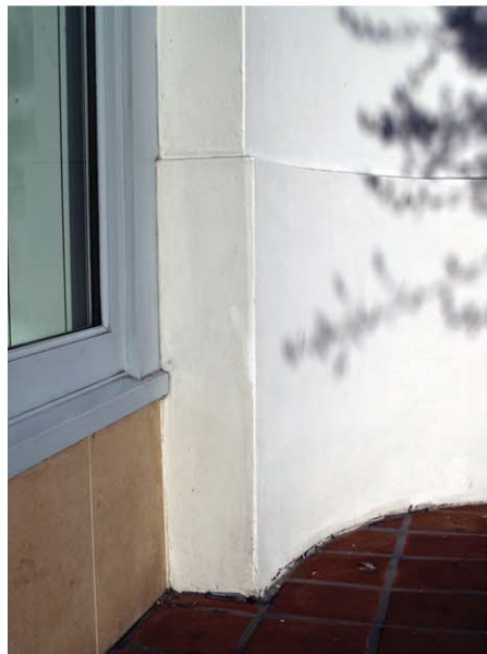
Wall Surfaces 5.jpg
